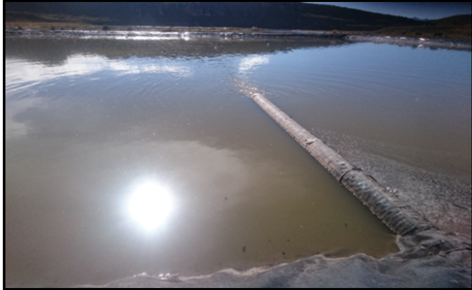
Figura 25: laguna aeróbica con acumulación de natas y materiales flotantes; aparición de malos olores.
